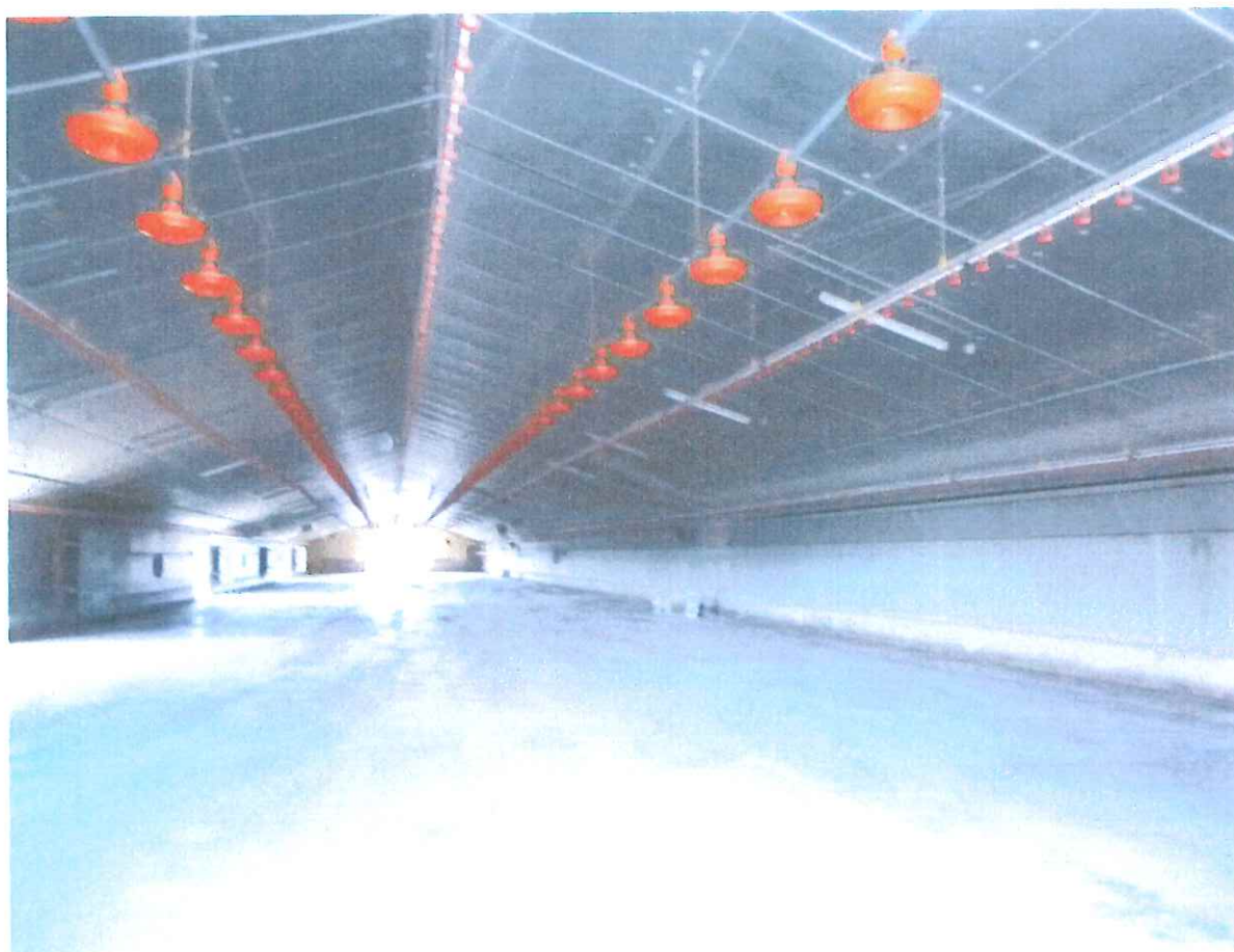
Vue du local d'élevage en vide sanitaire
